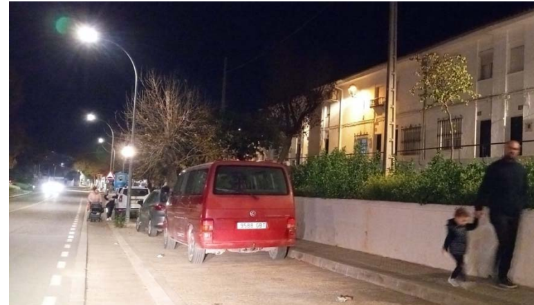
Foto 20 Falta de acerado adecuado y seguro
