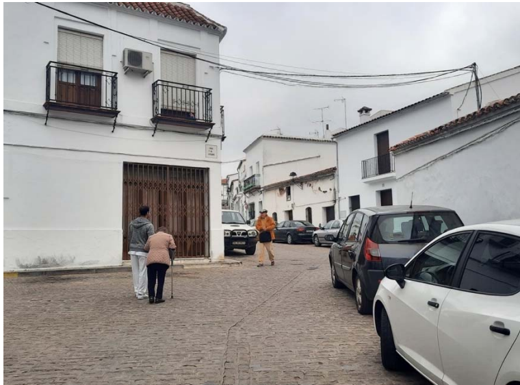
Foto 26. Caminando entre coches sobre pavimentación inadecuada
