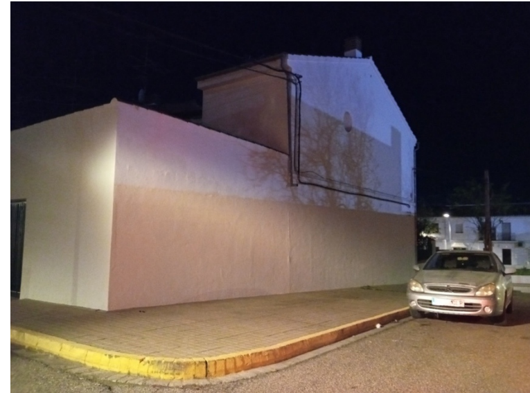
Foto 28. Muros ciegos en lateral de viviendas y acera sin rampa de acceso
